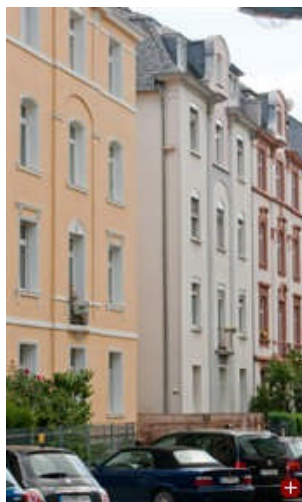
Drei Gründerzeithäuser im Frankfurter Nordend: Rechts das Original, ganz links eines mit außen gedämmter Fassade
